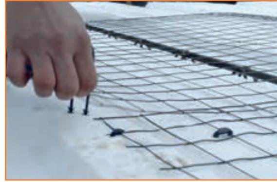
**2** Fixation du treillis 5x5.
