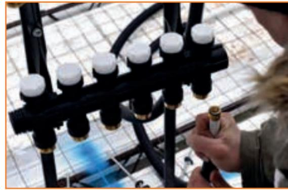
**4** Raccordement des tubes au collecteur.
